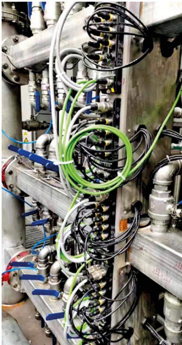
Relevante Prozessdaten und Messwerte werden über Turcks IO-Link-Master an die Steuerung übertragen
