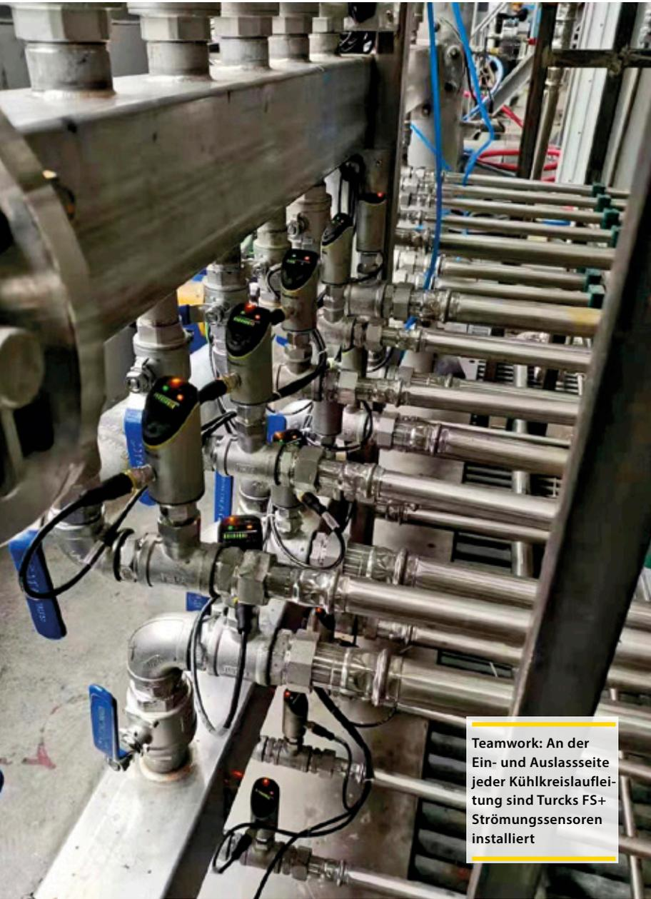
Teamwork: An der Ein- und Auslassseite jeder Kühlkreislaufleitung sind Turcks FS+ Strömungssensoren installiert
