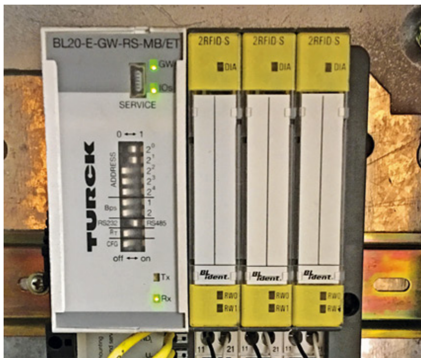
Das BL20-Gateway mit RS485-Anbindung stellt die Kommunikation zur Steuerung her, die RFID-S-Scheibe erlaubt eine einfache Anbindung ohne Programmierung
