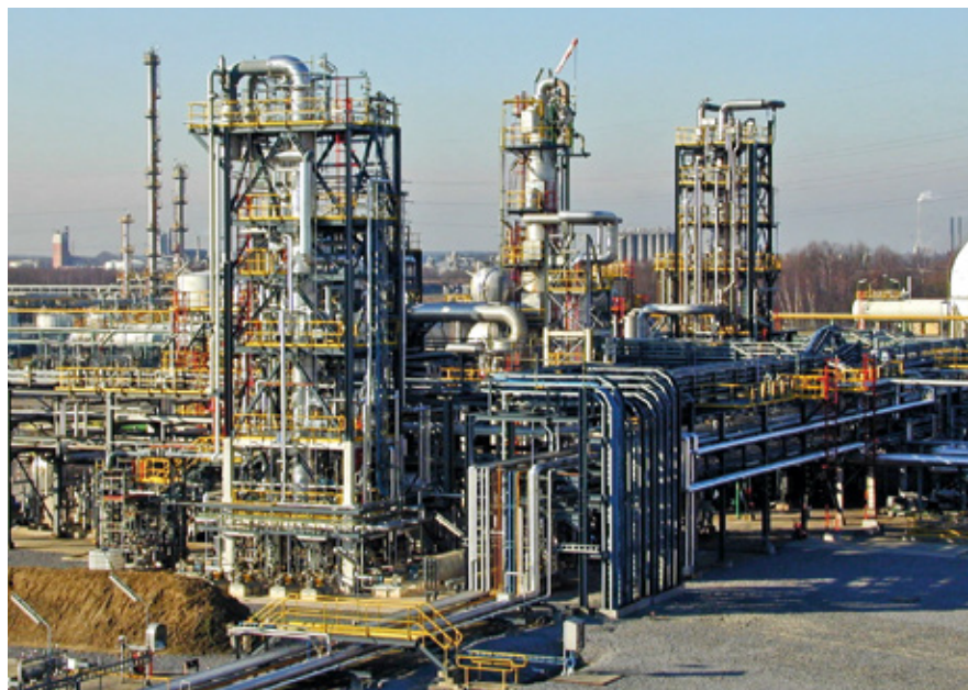
Die Anlage von CPChem im belgischen Beringen
