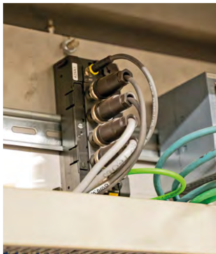
Kontrollleur mit großem Erfassungsbereich: Passiert eine Kassette den Näherungsschalter NI10U-M12, startet die SPS den Timer eines Erntevorgangs
