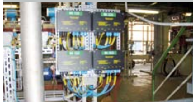
Bei Basell vertraut man auf die allseitige galvanische Trennung der Turck-Multibarrieren Seite 24
