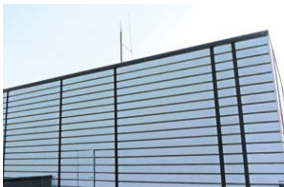
Die Antenne auf dem Dach der Filterhalle empfängt die Signale der 55 angeschlossenen Brunnen
