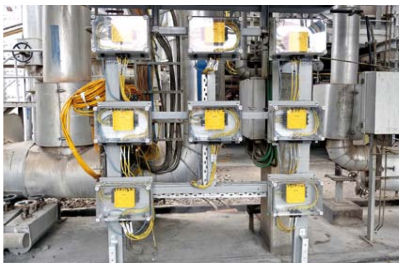
Für die sichere Verbindung zwischen Feldgeräten und DPC-Systemen sorgen 165 achtkanalige JBBS-Verteilerbausteine (Junction Boxes) von Turck
