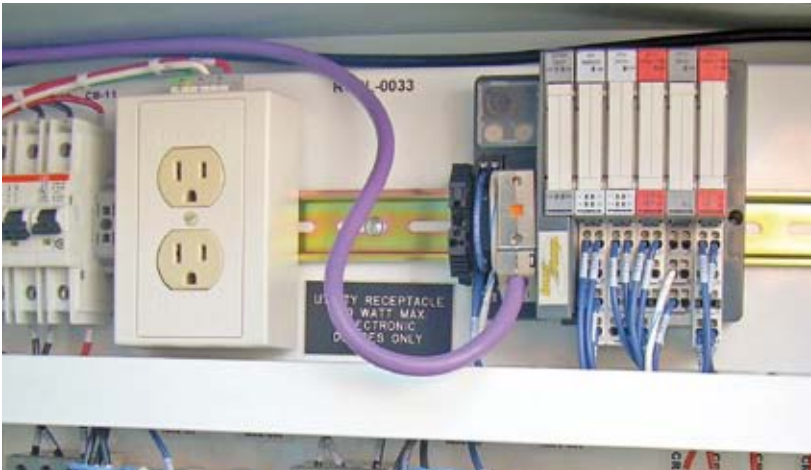
Turcks I/O-System BL20 koordiniert die ein- und ausgehenden Sensor- und Aktorsignale und kommuniziert per Profibus mit der Steuerung
