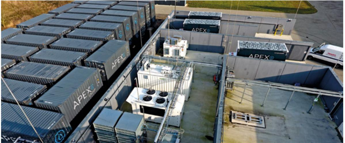
Die Pufferspeicher halten den Wasserstoff zur Betankung mit 350 Bar (LKW) oder 700 Bar (PKW) bereit
