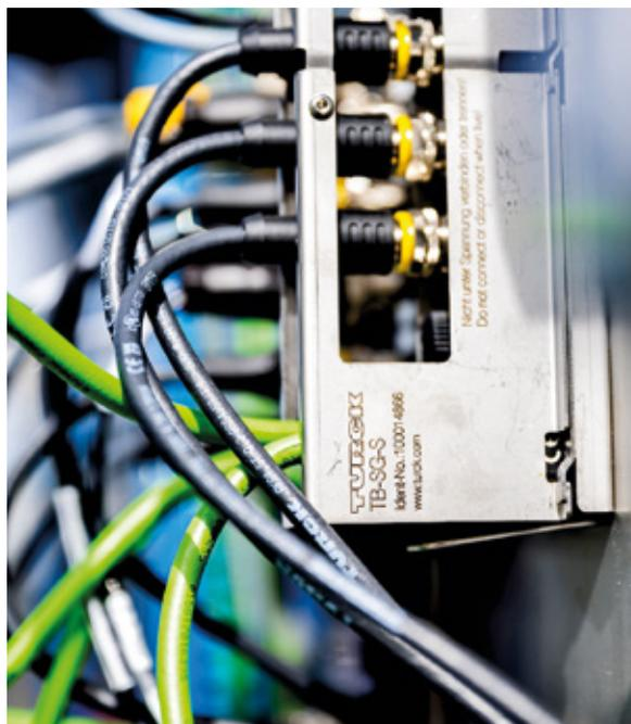
Mit den Edelstahl-Schutzgehäusen TB-SG sind fast alle TBEN-I/O-Module von Turck auch zum Einsatz in ATEX-Zone 2 zugelassen
