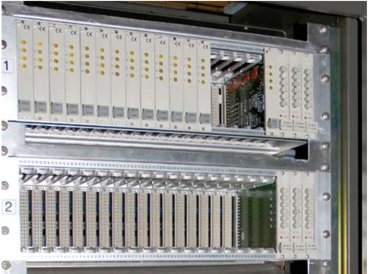
Raumgewinn: BP Lingen ersetzt immer mehr alte 19-Zoll-Messum- former durch Hutschienen- geräte von Turck
