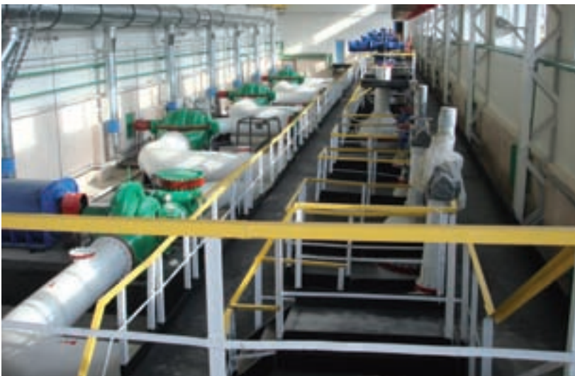
Pumpstationen mit Turck-Interfacemodulen sorgen dafür, dass der Öldruck in den Pipelines in Richtung Westen stets hoch genug bleibt
