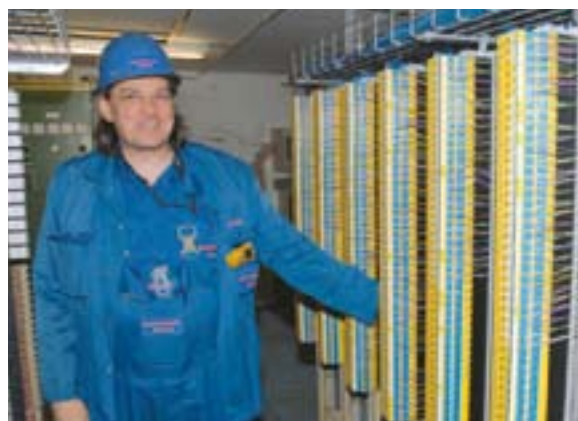
Holger Nitschke, BP Lingen, ist überzeugt von der kompakten Bauform und der einfachen Montage der Turck-Messumformer IM34
