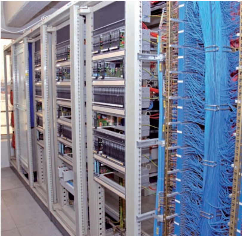
Seit der Modernisierung beherbergt eines der 19"-Racks (hinten links) statt der Interfacekarten zwei kompakte excom-Systeme
