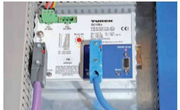
Der Segmentkoppler SC12Ex sorgt für die Ex-Trennung des eigensicheren Profibus-Segments
