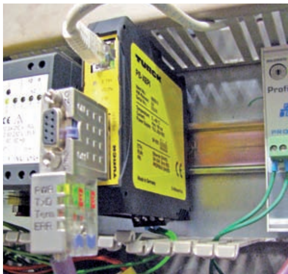
Ethernet und Webserver des PB-XEPI ermöglichen die Diagnose des Profibus-Netzes vom Büro aus
