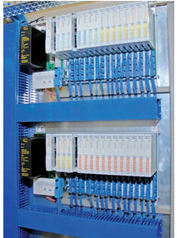
EAB Automation hat excom an nur einem Wochenende installiert und an die SPS angebunden
