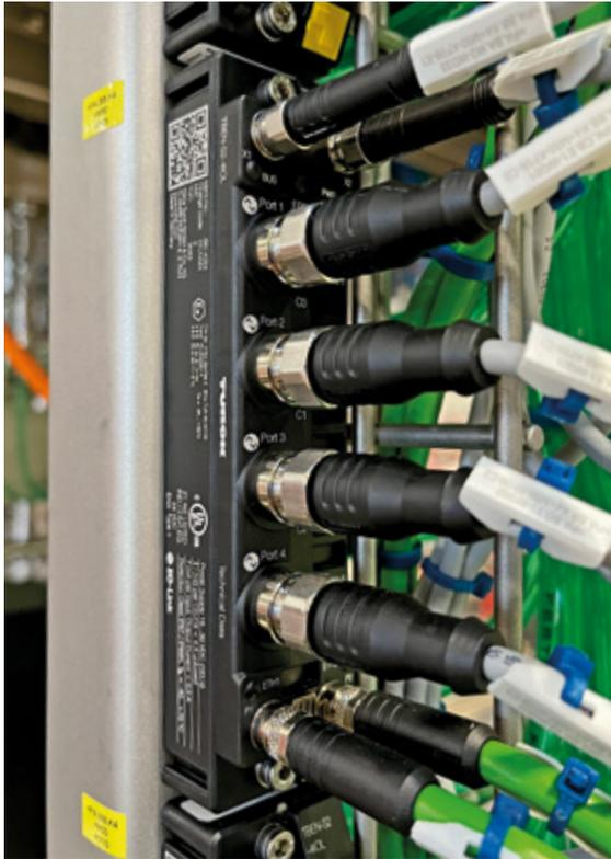
Masterclass: Turcks IO-Link Master TBEN-S2-4IOL ermöglicht die effiziente Nutzung von IO-Link und digitalen I/Os in einer ultrakompakten Montagegruppe am Prozessknoten zur Kühlung der Maschine
