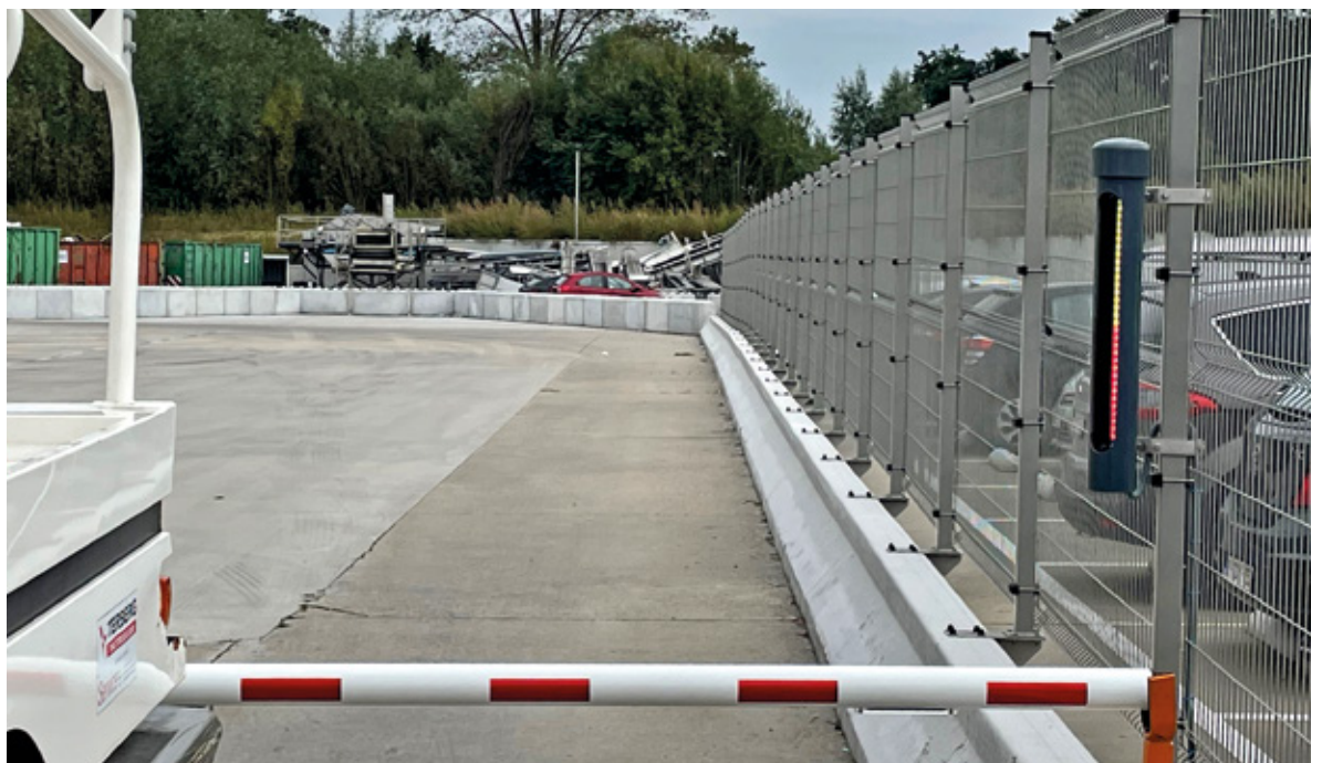
Die Leuchtpunkte der WLS27-LED-Leiste visualisieren einen Timer, der die Wartezeit des Fahrers herunterzählt
