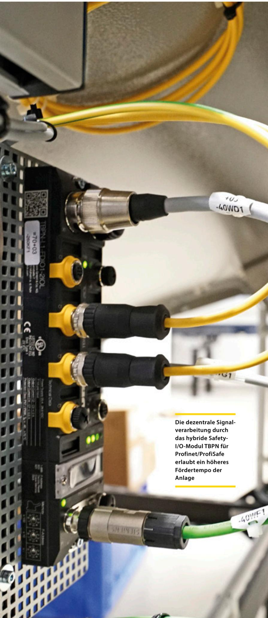
Die dezentrale Signalverarbeitung durch das hybride Safety-I/O-Modul TBPN für Profinet/ProfiSafe erlaubt ein höheres Fördertempo der Anlage
