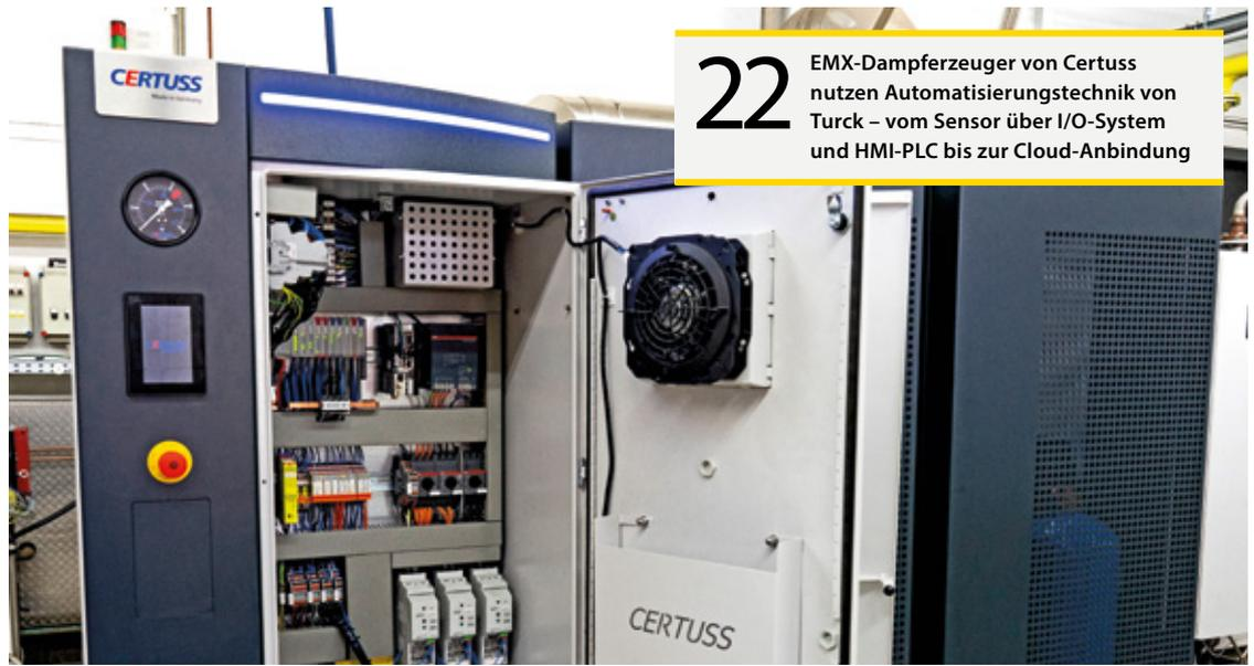
**22** EMX-Dampferzeuger von Certuss nutzen Automatisierungstechnik von Turck – vom Sensor über I/O-System und HMI-PLC bis zur Cloud-Anbindung
