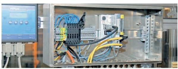
Das CoDeSys-programmierbare Gateway des BL20-I/O-Systems übernimmt die gesamte RFID-Kommunikation
