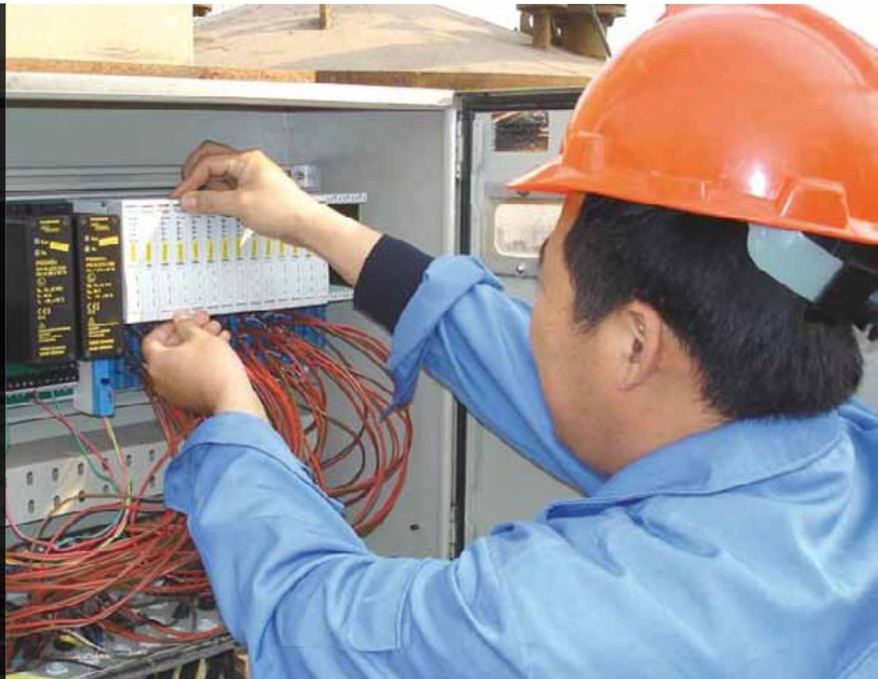
**Vorteil des modularen Aufbaus der excom-Station: Die bis zu 16 I/O-Module lassen sich – inklusive der Netzteile – im laufenden Betrieb in Zone 1 austauschen**
