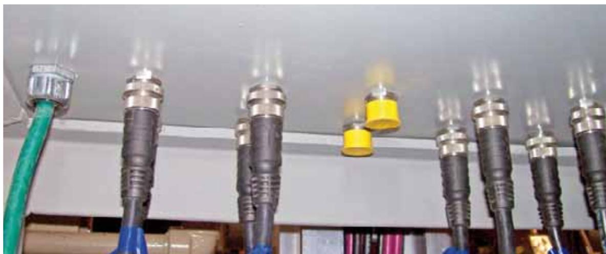
**Der Anschluss des an einem anderen Ort vorkonfigurierten Steuerungsschranks war dank der Turck-Steckverbinder in wenigen Minuten erledigt**
