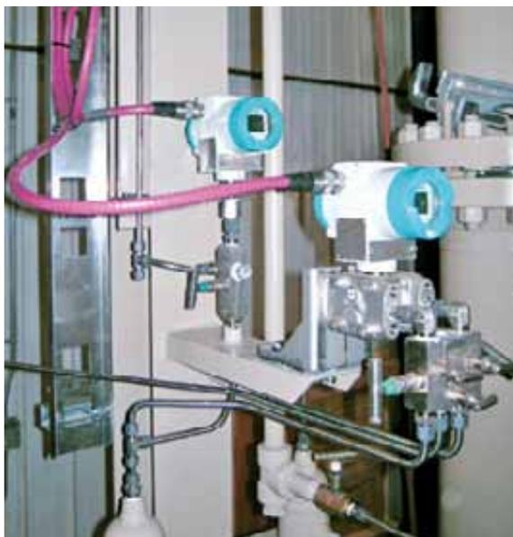
Die Transmitter sind über extrem robuste Kabel mit Metallmantel mit den Verteilerboxen verbunden
