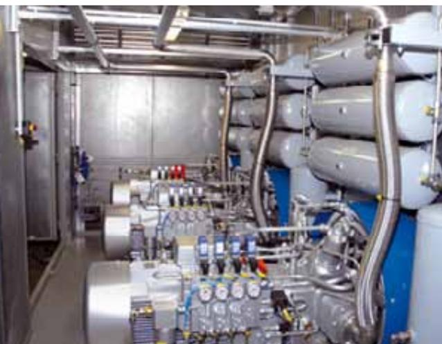
installieren die Anlagenbauer dazu bis zu vier Verdichter und bis zu 48 Gas-Speicherflaschen in die Beton- oder Stahlblechcontainer.
