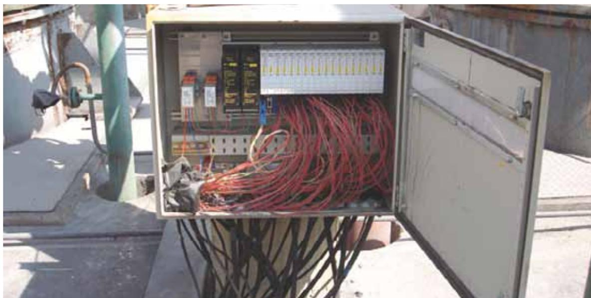
Die aus Netzteilen, Gateway, I/O-Modulen und Trägersystem bestehenden excom-Remote-I/Os können mit 24-V-Gleich- oder 230-V-Wechselspannung aufgebaut werden
