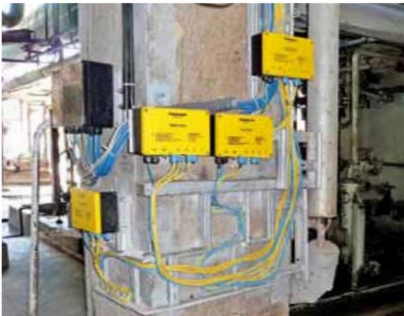
In Ex-Zone 1 werden die Multibarrieren MBD49-T415-Ex mit je vier eigensicheren Ausgängen eingesetzt
