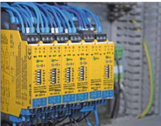
**Eigensichere Trennschaltverstärker übertragen die Signale der Drucksensoren an die Steuerung**
