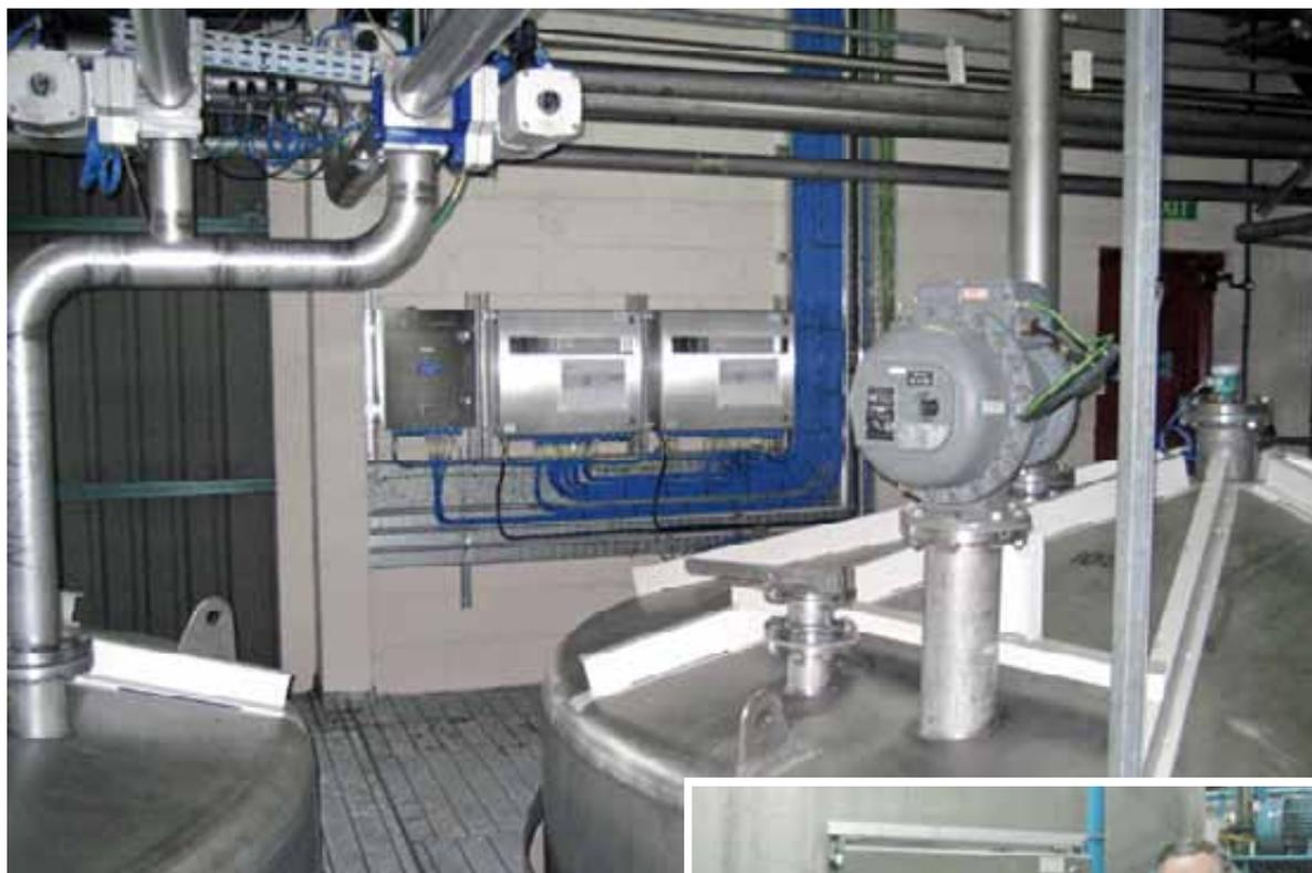
**IDL hat alle zwölf excom-Schränke mit einem Belegungsplan bestückt, der jeden Ausgang einem Feldgerät zuordnet**
