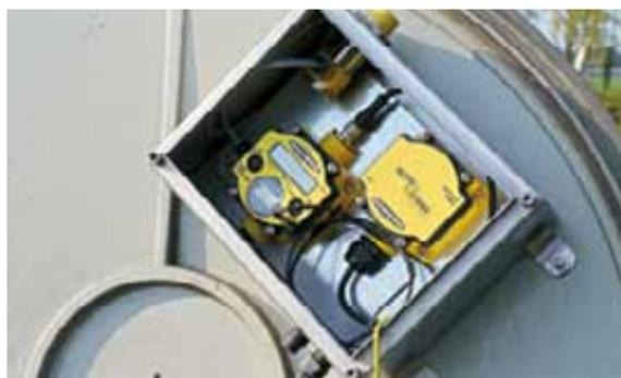
Die IP67-Komponenten der DX80-Anlage samt Sensor sind in einem Schaltkasten installiert
